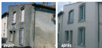
Réfection de façade
