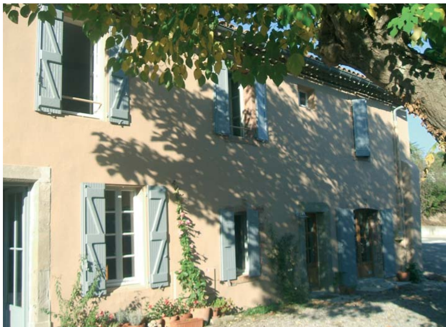
Réfection de façade
