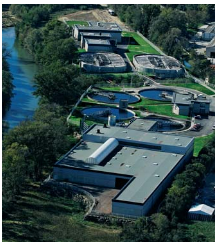
Station d'épuration de Carcassonne Photo Degrémont - Augusto Da Silva GRPHIX - Image
