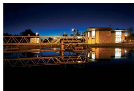
Station d'épuration de Carcassonne
